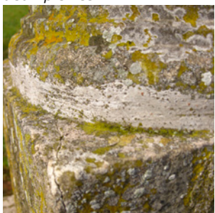
Joint au mastic entre deux pierres
