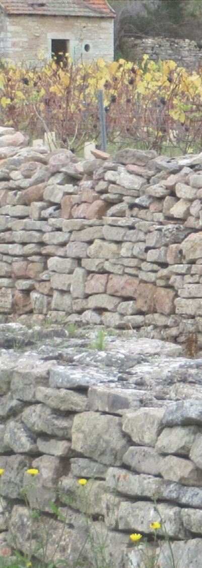
Mur de soutènement maçonné
