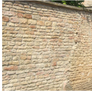
Mur de soutènement maçonné
