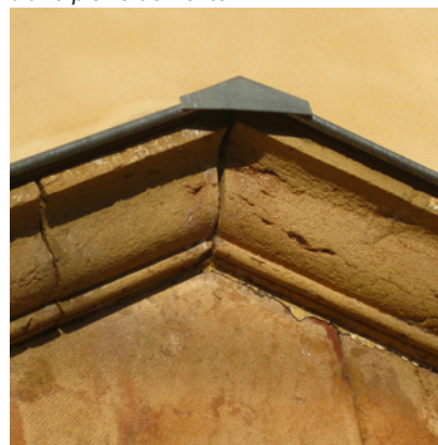
Protection d'une pierre de fronton
